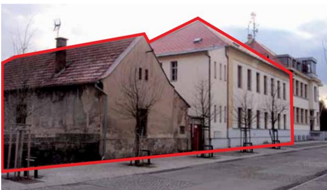
Obr. 10.10: část školy určené k demolici (Informační listy - č.2 2013)
