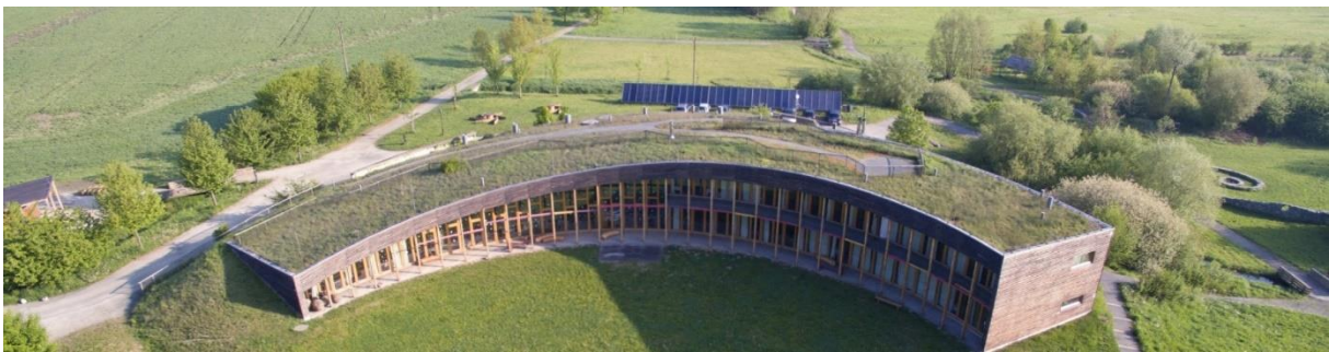
Obrázek 1 Ekologická stavba – Sluňákov
