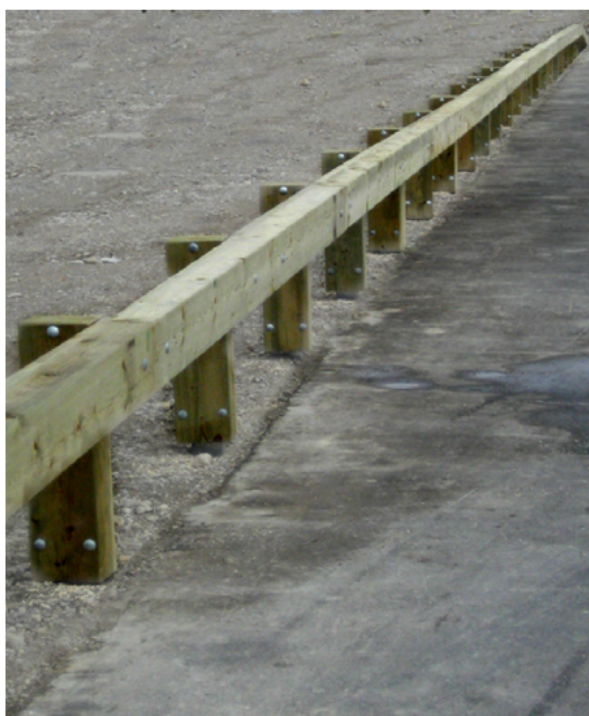
Obr. 7.20 Dřevěné svodidlo s ocelovou výztuhou[17]
