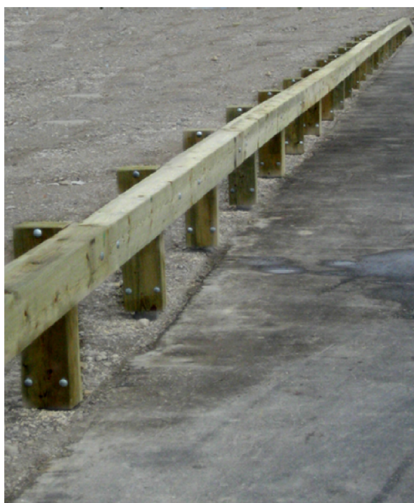
Obr. 7.20 Dřevěné svodidlo s ocelovou výztuhou[17]
