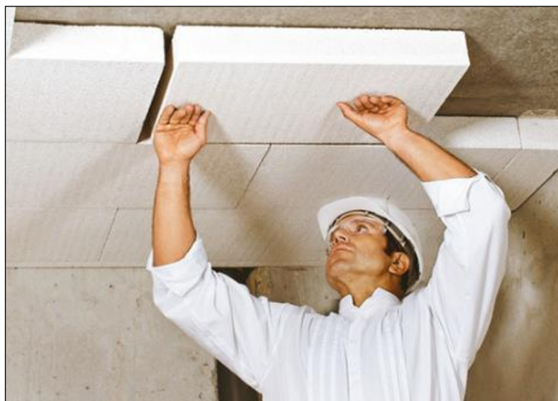
Obr. 15 Ukázka izolace stropu suterénu pomocí polystyrenu [32]
