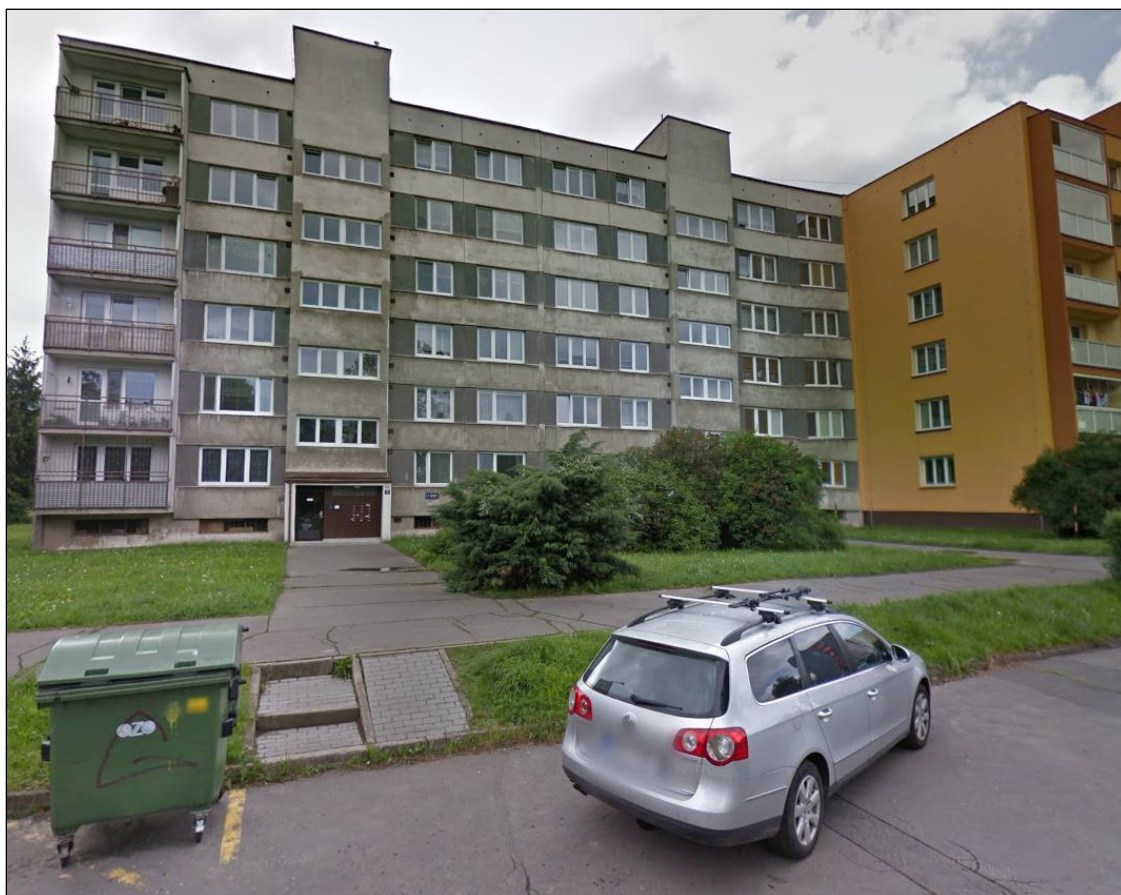
Obr. č. 31 – Původní stav bytového domu již po realizaci výměny oken
