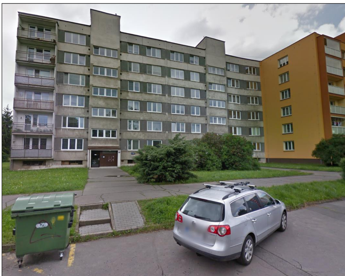
Obr. č. 31 – Původní stav bytového domu již po realizaci výměny oken
