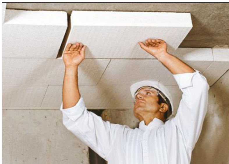
Obr. 15 Ukázka izolace stropu suterénu pomocí polystyrenu [32]
