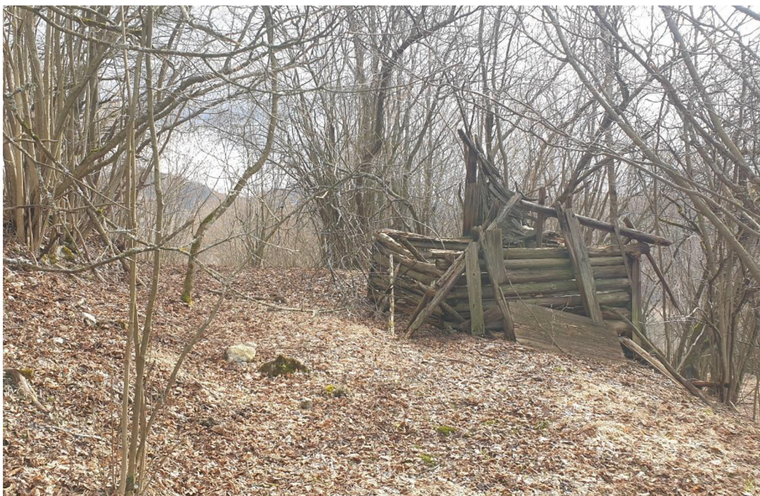
Príloha 13 Rozpadávajúca sa hospodárska budova – seník na HŠPK v oblasti Ružomberok.
