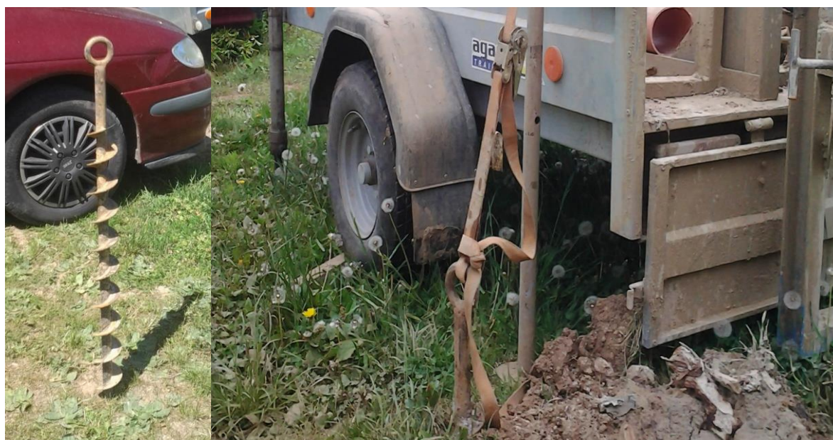
Obr.4-31. Ukotvení vrtné soupravy zemními vruty a popruhy
