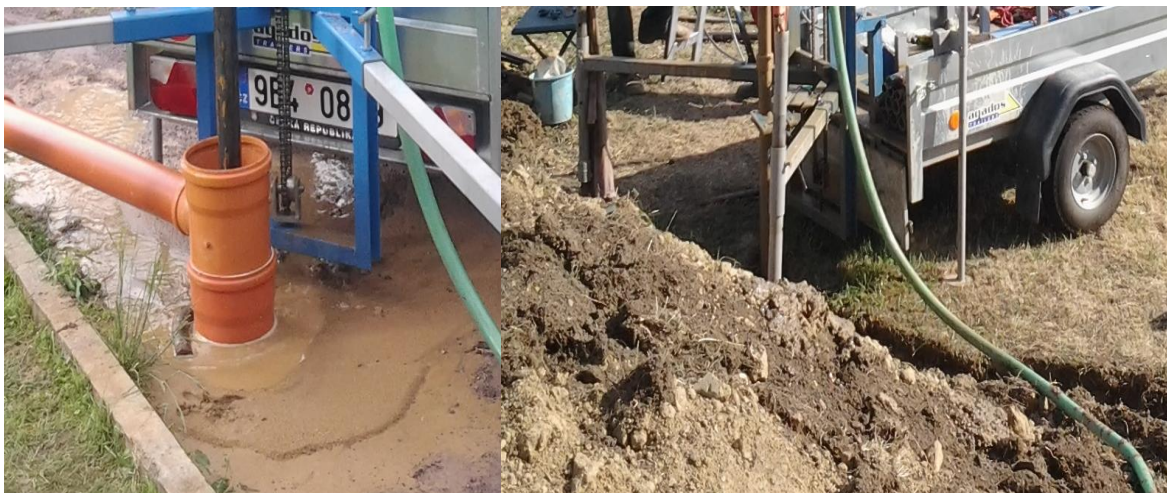
Obr.6-2. Původní a nové řešení vlasního výplachu z vrtu
