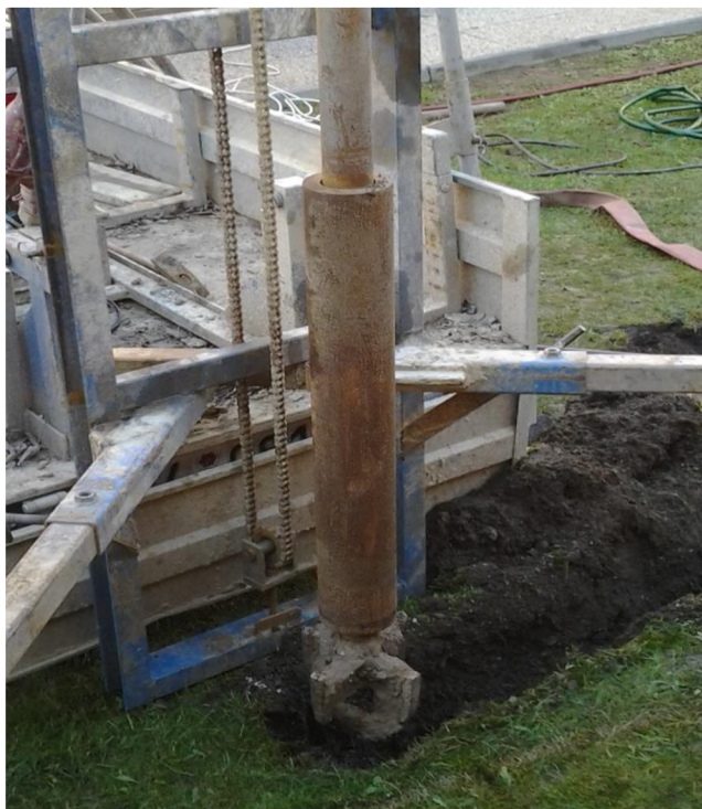
Obr.6-5. Zátěžka umístěná za vrtací korunkou
