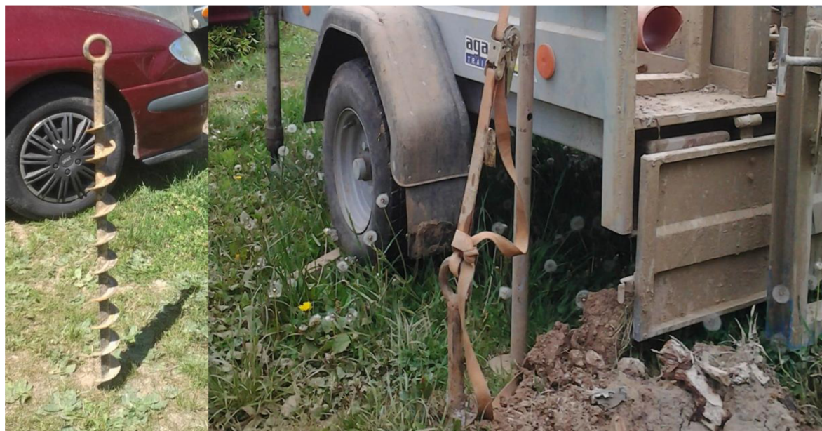
Obr.4-31. Ukotvení vrtné soupravy zemními vruty a popruhy
