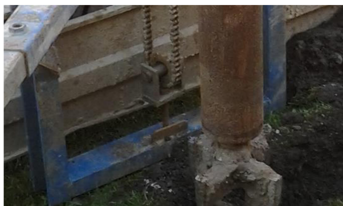
Obr.4-24. Napínání řetězu vrátku ve spodní části vrtné věže
