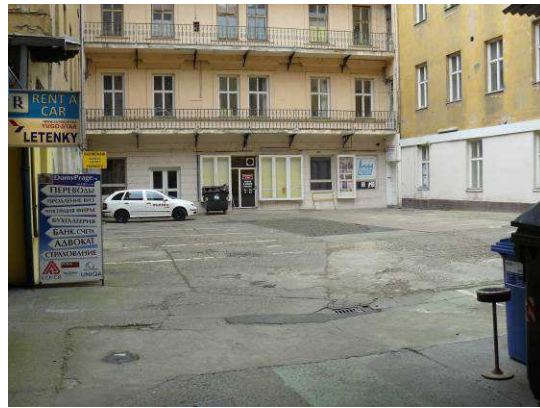
Obr. 60 Degradovaný stav prostoru vnitrobloku v Jindřišské ulici
