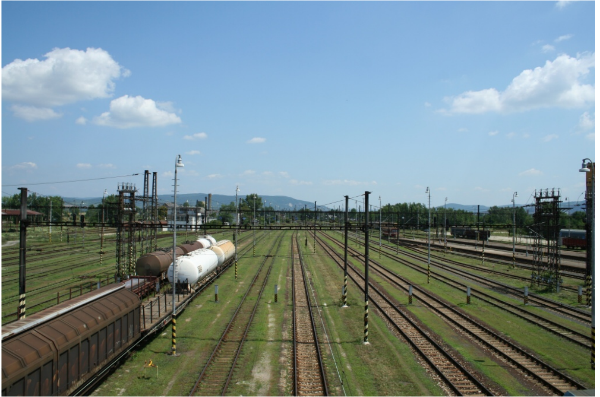
Obr. 4.1 Železničná stanica Štúrovo
