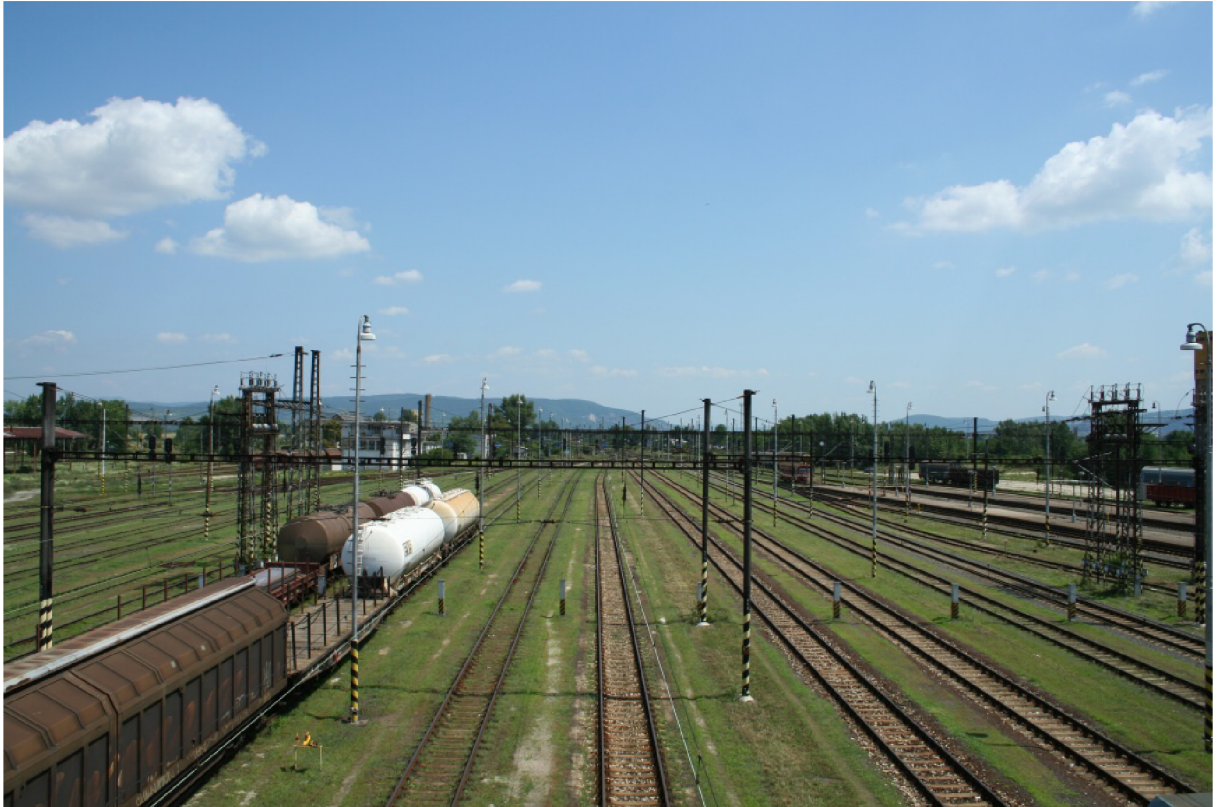
Obr. 4.1 Železničná stanica Štúrovo
