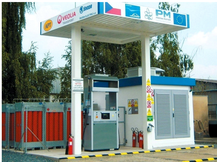
Obrázek 12: Povinné bezpečnostní značky na čerpací stanici (33)
