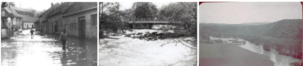
Obr. 6.8 – 6.10: Zatopená ulice Mjr. Šandery, pohled na most a roztroušenou zástavbu [49], [52]
