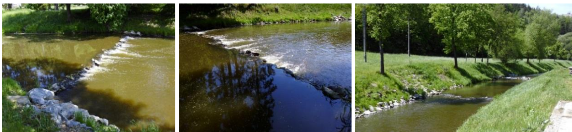
Obr. 3.35 - 3.37: Spádové stupně řešeného úseku č. 2
