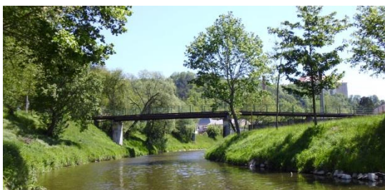
Obr. 3.44: Lávka pro pěší na ř. km 34,895
