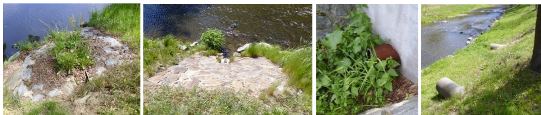
Obr. 3.50 - 3.53: Výustě řešeného úseku č. 2
