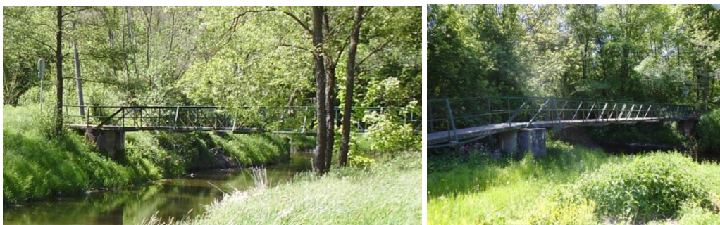
Obr. 3.84 a 3.85: Lávky pro pěší v řešeném úseku č. 3
