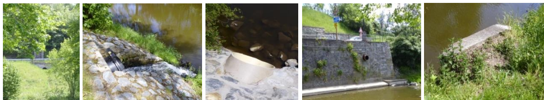
Obr. 3.45 - 3.49: Výustě řešeného úseku č. 2
