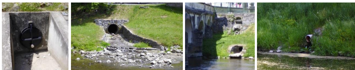
Obr. 3.59 - 3.62: Výustě řešeného úseku č. 2
