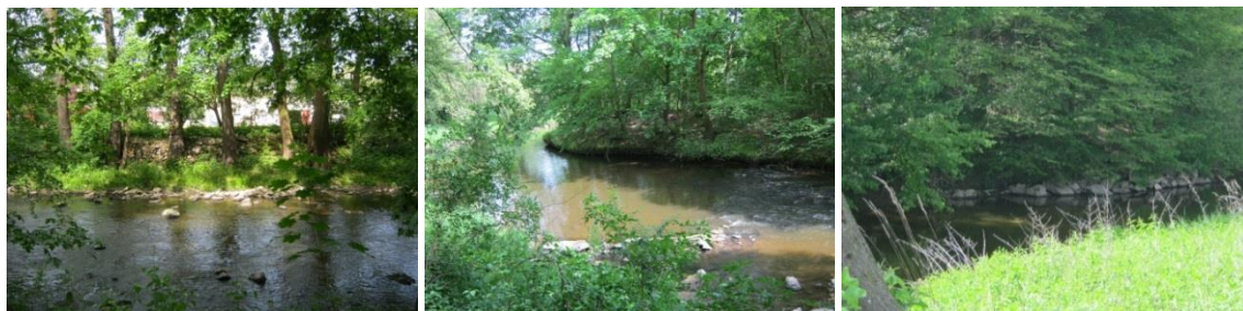
Obr. 3.2 - 3.4: Kamenná zeď, podemletý břeh, kamenná záhozová patka
