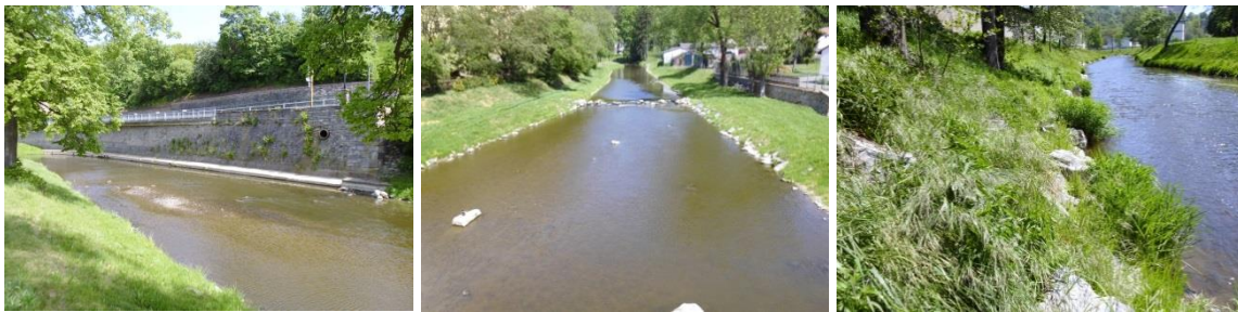
Obr. 3.26 – 3.28: Opěrná zeď, kamenná záhozová patka, kamenná rovnanina na břehu koryta
