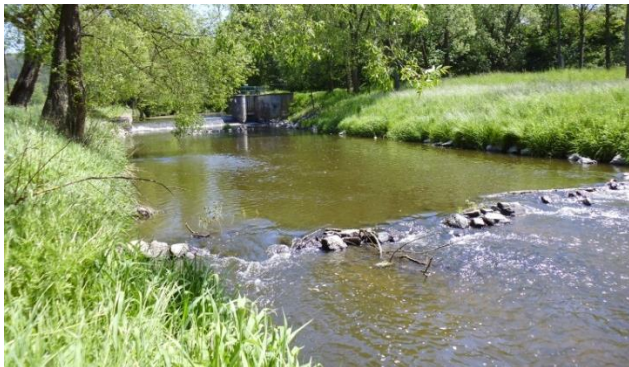
Obr. 3.83: Spádový stupeň řešeného úseku č. 3
