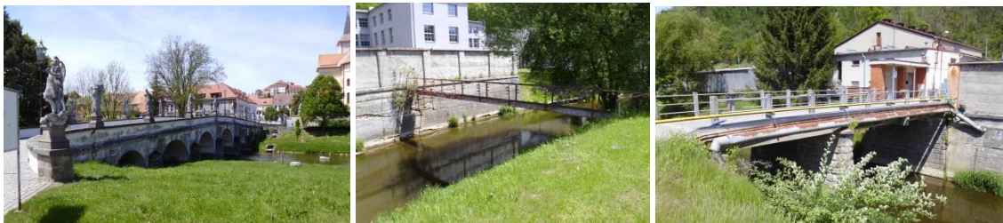
Obr. 3.41 - 3.43: Silniční most, lávka pro pěší, silniční most v řešeném úseku č. 2
