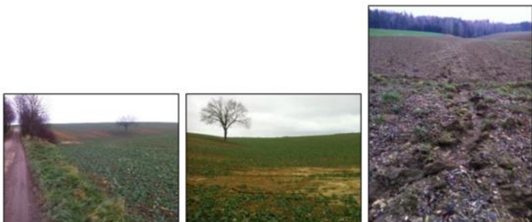
Obrázek 35: Území nad cestou C5 a erozní rýha od propustku pod cestou
