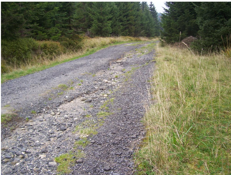
Obrázek č. 36: Štěrkový povrch - porušení IV. třídy
