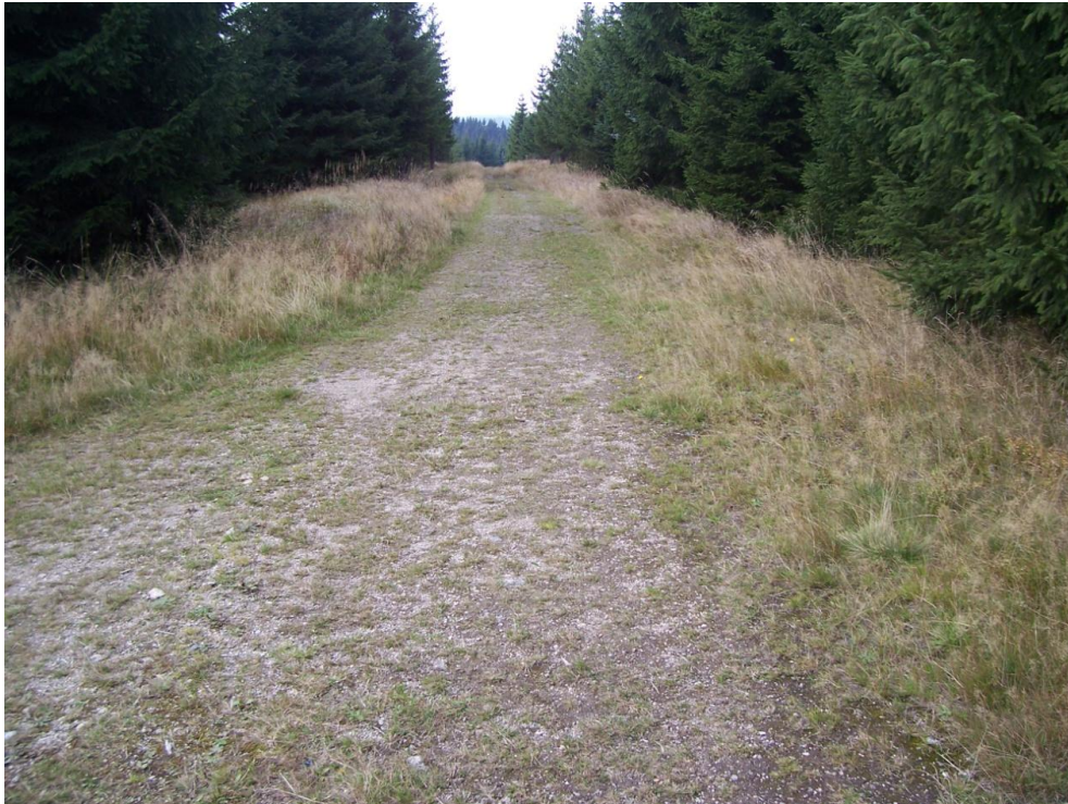
Obrázek č. 40: Zemní cesta - porušení III. třídy
