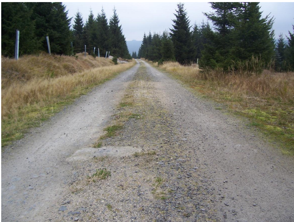
Obrázek č. 34: Štěrkový povrch - porušení II. třídy
