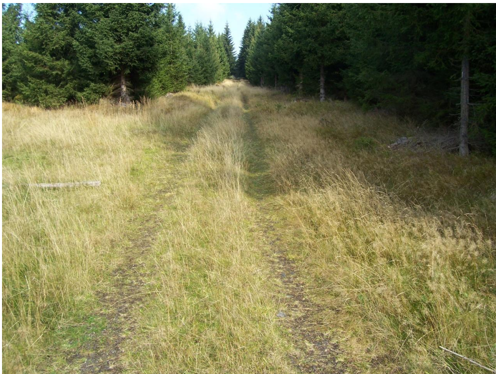
Obrázek č. 41: Zemní cesta - porušení IV. třídy
