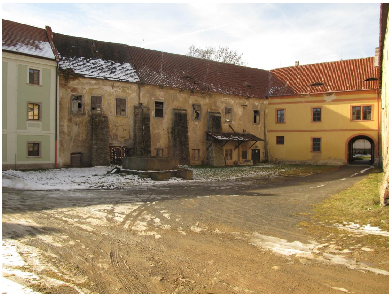
Obr. č. 8: Budova bývalého pivovaru a prelatury (Čižmarová, 2014)
