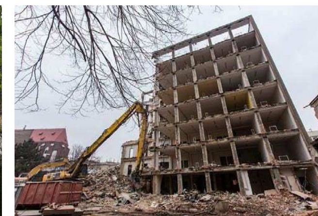
Obr. č. 4.: Demolice bývalého ministerstva zemědělství, Opava.
