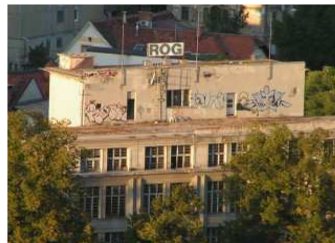
Obr. č. 20.: Hlavní tovární budova
