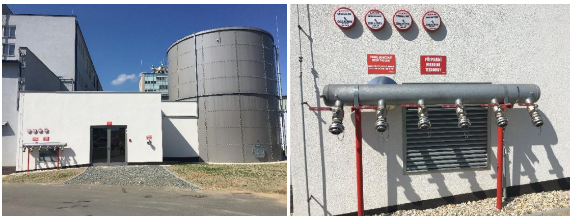
Obr. 5 Nádrž o objemu 600 m 3 s přidruženou strojovnou, Obr. 6 Venkovní armatura pro napojení mobilní techniky 15
