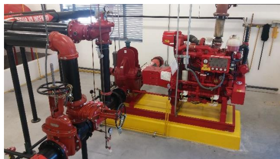
Obr. 8 Dieselové čerpadlo 21
