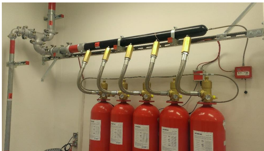
Obr. 38 Ukázka napojení tlakových lahví s plynem 75
