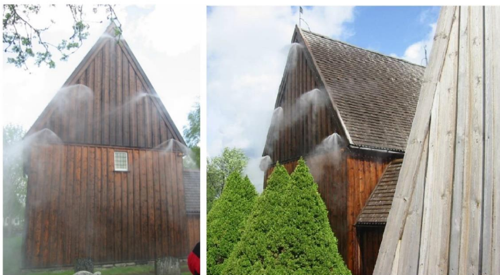
Obr. 31 Test funkčnosti zkrápění fasády kostela ve Švédsku 60
