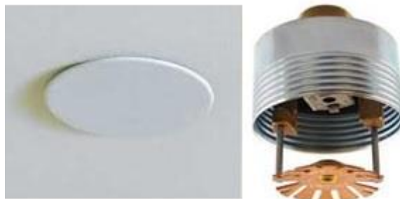
Obr. 23 Skrytý sprinkler 41
