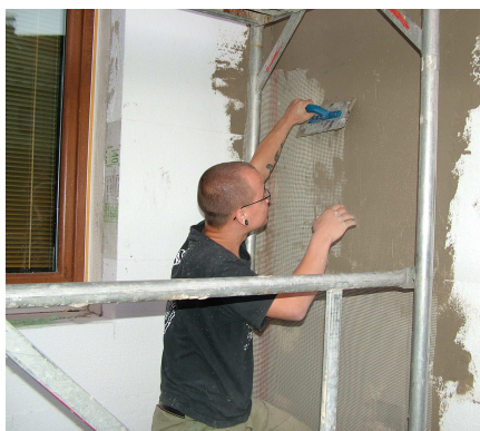
Obr. č. 28 Nanášení výztužné vrstvy
