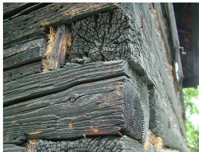
Obr. č. 4 Olejová impregnace smrkového trámu
