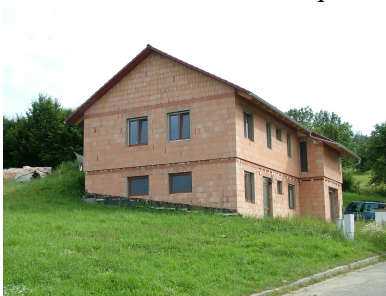
Obr. č. 14 Rodinný dům před zateplením
