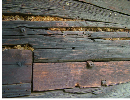
Obr. č. 3 Izolace mechem - původní dřevostavba, Valašské Klobouky
