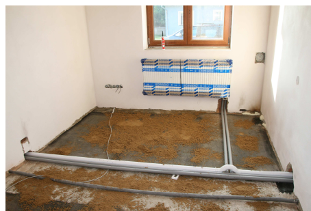
Obr. č. 31 Příprava na tepelnou izolaci podlahy
