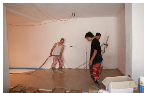
Obr. č. 33 Lití anhydritu na podlahovou zateplenou vrstvu
