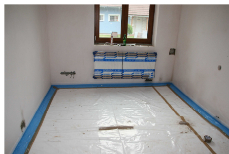
Obr. č. 32 Zateplená podlaha, připravená na lití anhydritem
