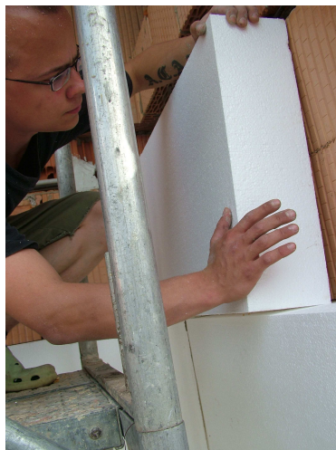
Obr. č. 26 Lepení desek tepelné izolace
