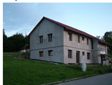
Obr. č. 15 Rodinný dům po zateplení
