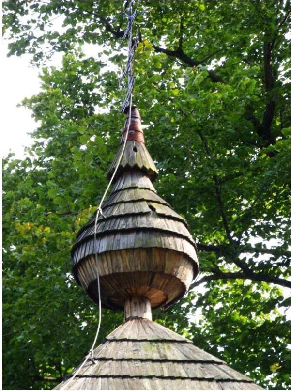
Obr. 13 Příkra – narušená cibulka věže
