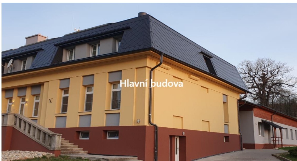
Obrázek č.14 Budova dětského domova
