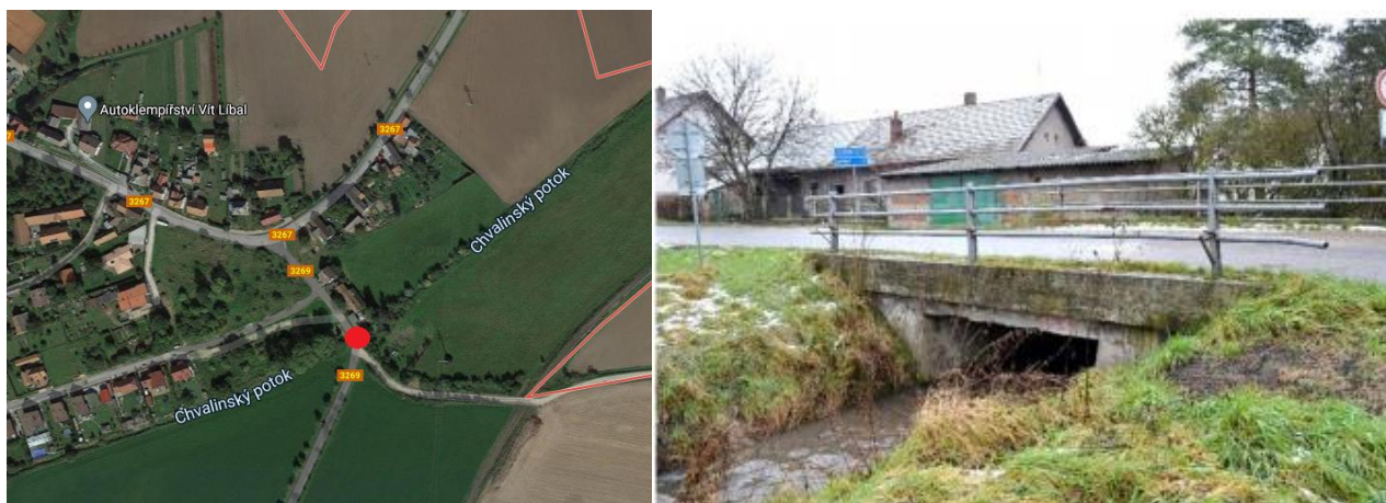
Obr. 24 Umístění propustku na mapě vlevo, detail zmiňovaného propustku
