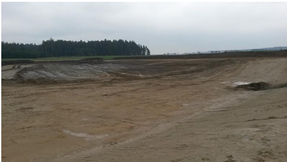
Obr. 5 Výstavba malých vodních nádrží Nové Veselí
