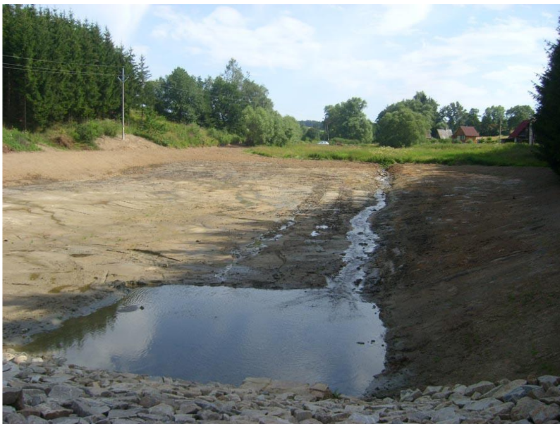
Obr. 4 Výstavba vodní nádrže Cerekvička
