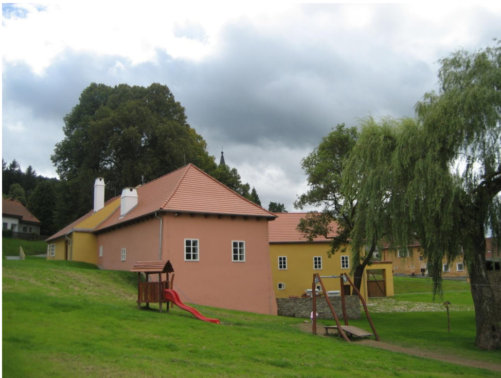
Obrázek č. 10 Budova fary po kompletní rekonstrukci
