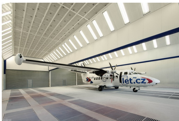
Obrázek č. 2 - Lakovna letadel. Zdroj KOVOFINIŠ s.r.o. (2018b).
