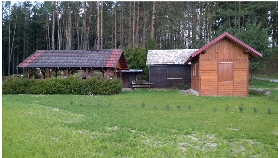
Obrázek č. 4: Pohled na budovy a přístřešek
