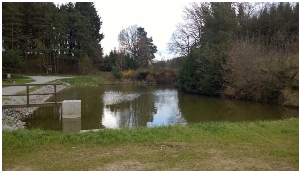
Obrázek č. 7: Pohled na hlavní nádrž s novým požerákem
