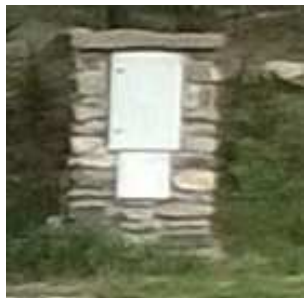
Obrázek č. 19: Nově postavená rozvodová skříň
