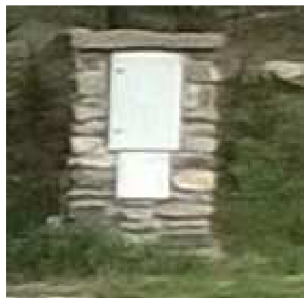
Obrázek č. 19: Nově postavená rozvodová skříň
