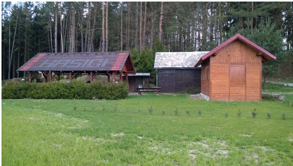
Obrázek č. 4: Pohled na budovy a přístřešek
