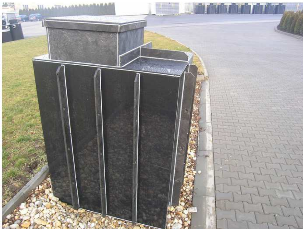
Obr. 1: Vodoměrná šachta hranatá nesamonosná [4]
