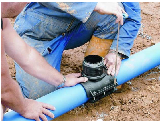
Obr. 13: Osazení elektrotvarovky [8]
