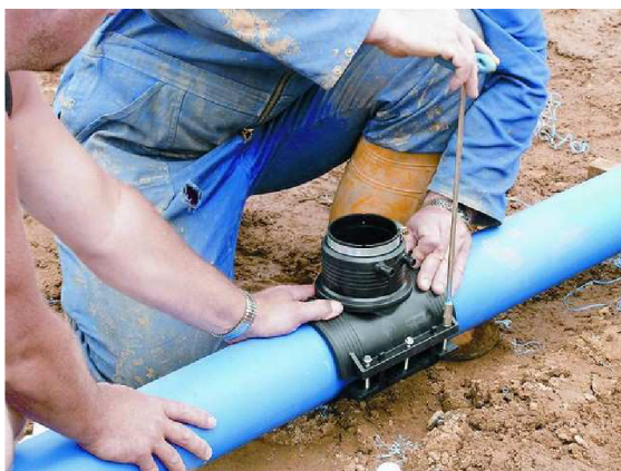
Obr. 13: Osazení elektrotvarovky [8]
