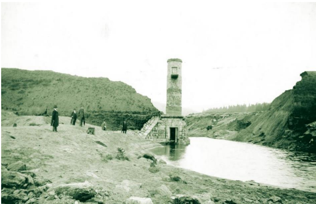
Příloha č. 10: Místo havárie na Bílé Desné – protržení přehradní hráze, 21. 9. 1916 (pohled ze vzdušné strany hráze) (Zdroj: Šámalová 2016).
