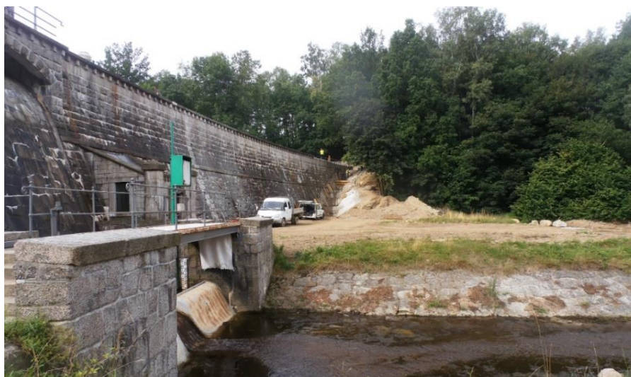
Obrázek 13: Probíhající oprava hráze přehradní nádrže Fojtka (Zdroj: vlastní foto, 17. 7. 2018)
