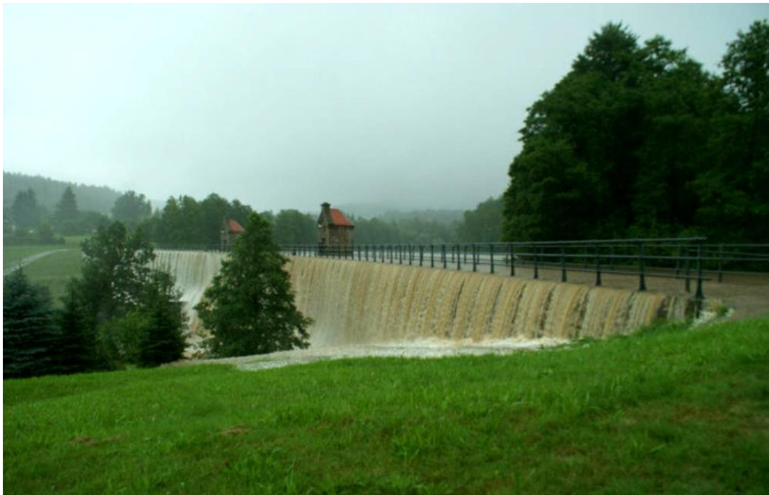
Příloha č. 9: Přetékající voda přes korunu hráze přehradní nádrže Mlýnice, 7. 8. 2010 (Zdroj: ČHMÚ, 2010a).
