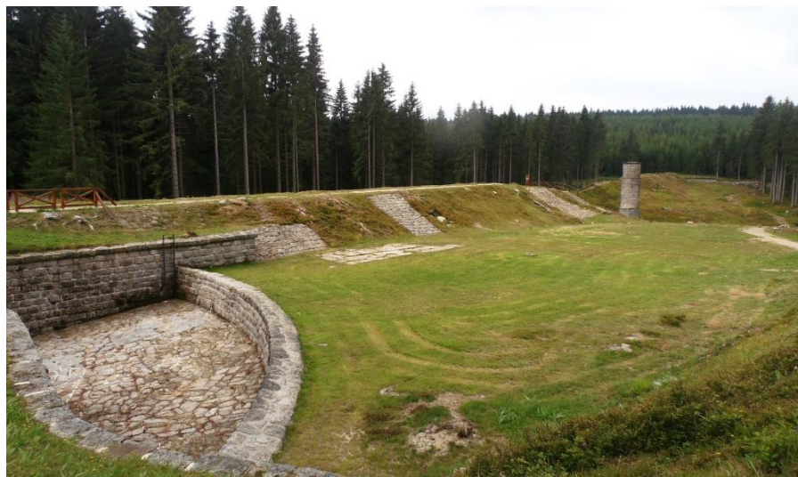
Obrázek 19: Současný stav areálu Protržené přehrady – v pozadí šoupátková věž a zbytky hráze (Zdroj: vlastní foto, 19. července 2018)
