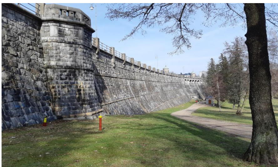
Obrázek 15: Hráz přehradní nádrže Mšeno (Zdroj: vlastní foto, 31. 3. 2019)
