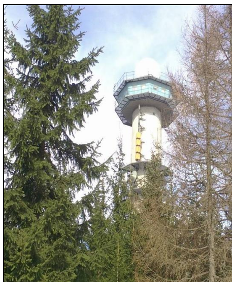
Obr. č. 17 Meteoradar na vrcholu Praha
