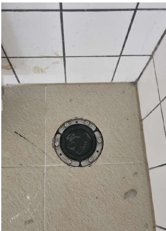
Obr. 2.5 Průchodka skrz podlahu - průměr 200 mm
