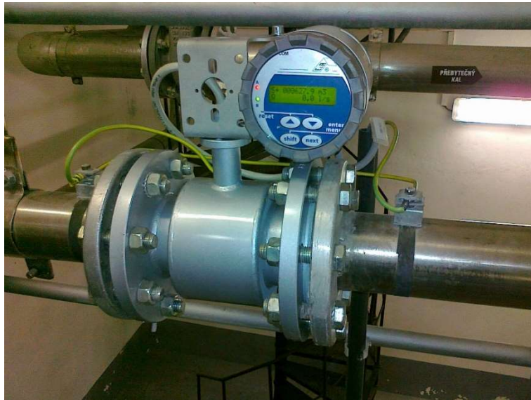
Obr. 7.2 Magneticko - indukční průtokoměr ELA Brno DN 80 [8]
