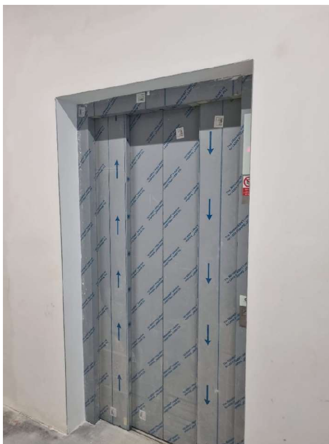
Obr. 2.1 Vstup do výtahu
