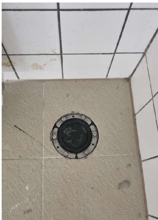
Obr. 2.5 Průchodka skrz podlahu - průměr 200 mm
