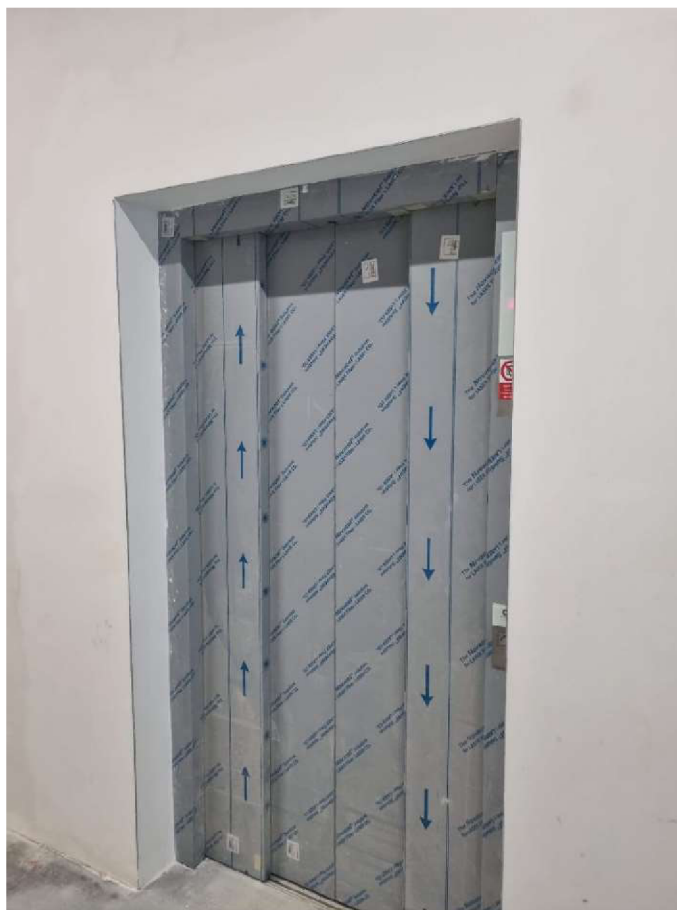
Obr. 2.1 Vstup do výtahu
