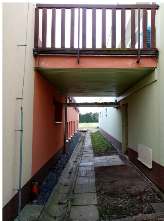
Obr. 11 Vstup do 1NP pod mostem
