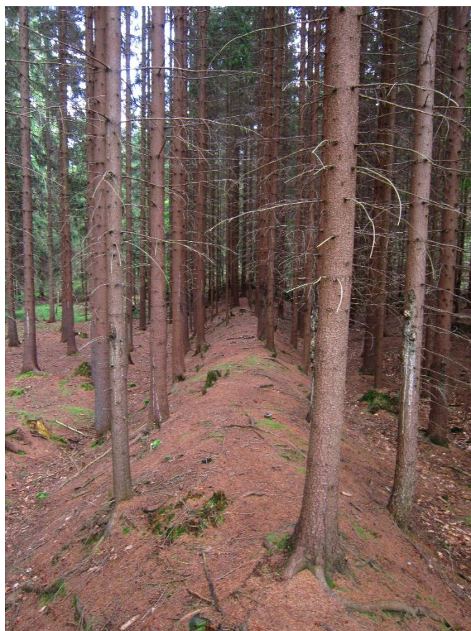
Foto č. 20: Pohled na korunu valu objektu 33
