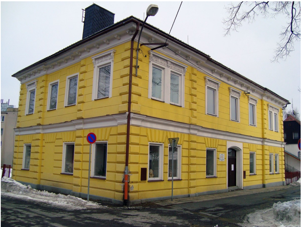
10. Budova Základní umělecké školy Rýmařov (foto r. 2010)
