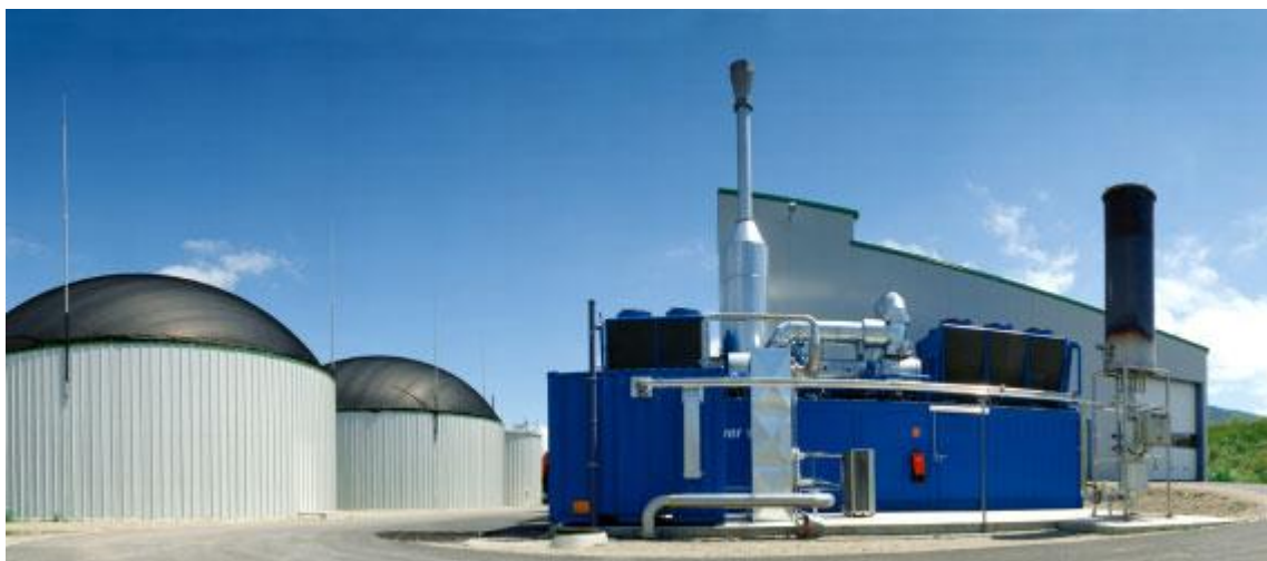
Obr. 1 Bioplynová stanice na mokrou fermentaci [23]
