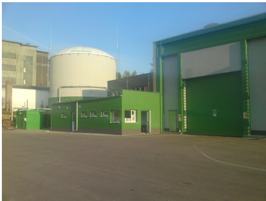
Obr. 7 Bioplynová stanice na zpracování biologicky rozložitelných odpadů Žďár nad Sázavou [16]
