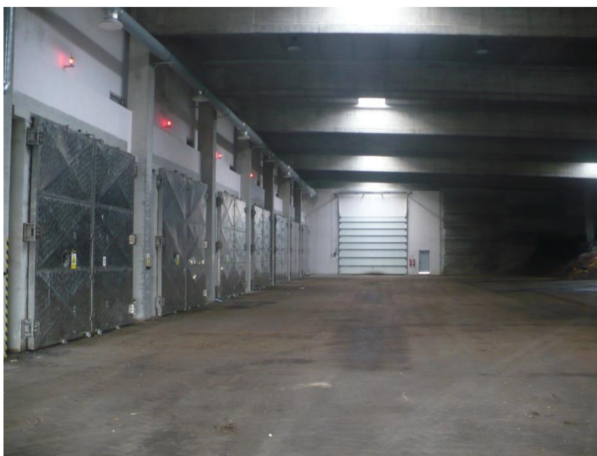
Obr. 8 Fermentační plynotěsné komory [16]
