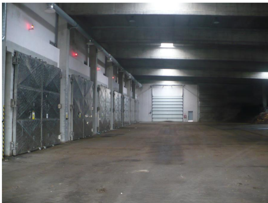
Obr. 8 Fermentační plynotěsné komory [16]
