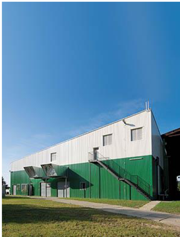
Obr. 10 Komunální bioplynová stanice Šumperk – Temenice [14]
