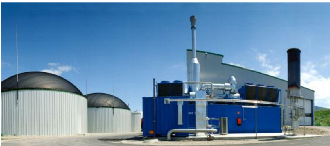
Obr. 1 Bioplynová stanice na mokrou fermentaci [23]
