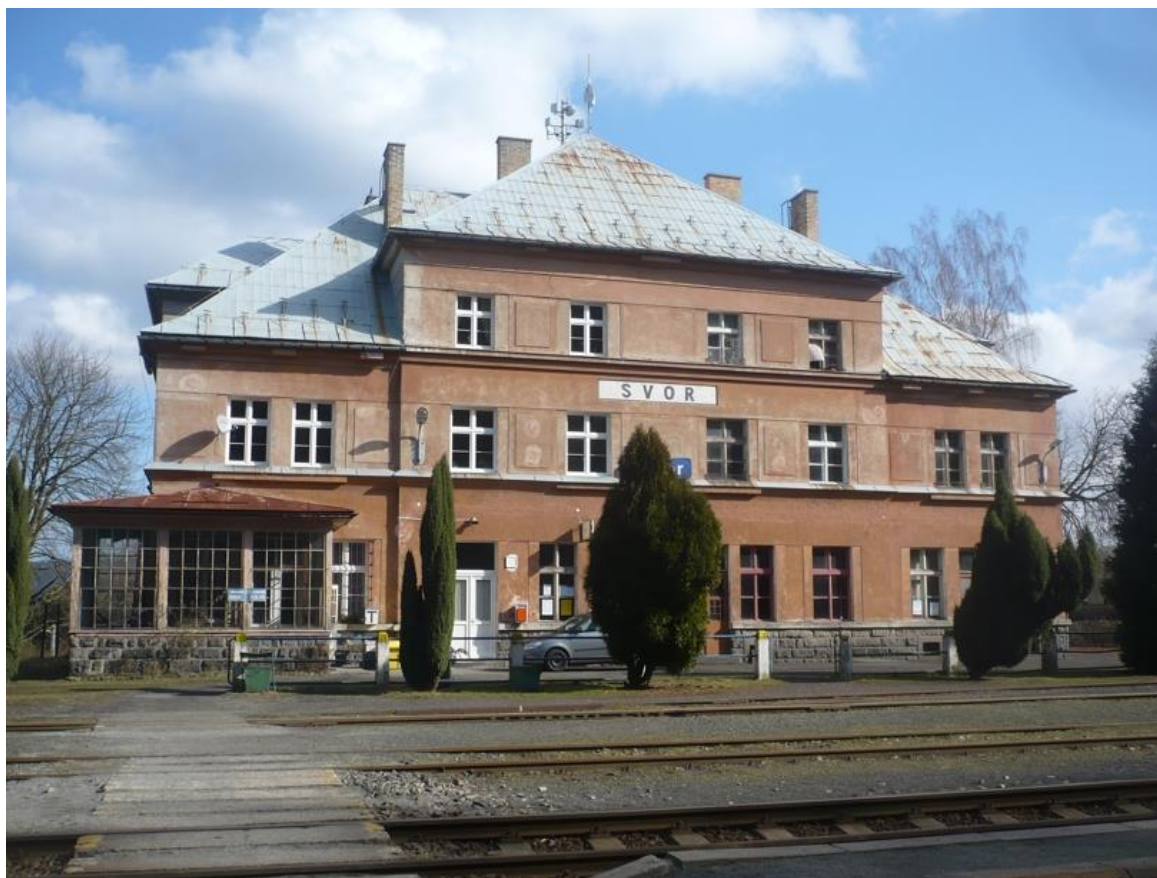
A1 – Příjímací budova ve Svoru postavená roku 1924 (pohled od kolejiště) 1
