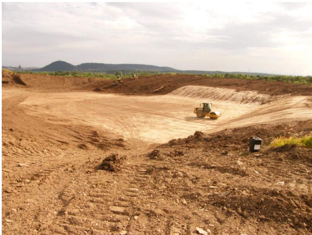
Obr.č. 9: Skládka Celio a.s. v Litvínově
