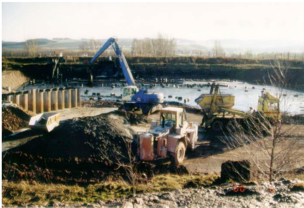
Obr. č. 3: : Dekontaminace laguny v Neukirchenu
