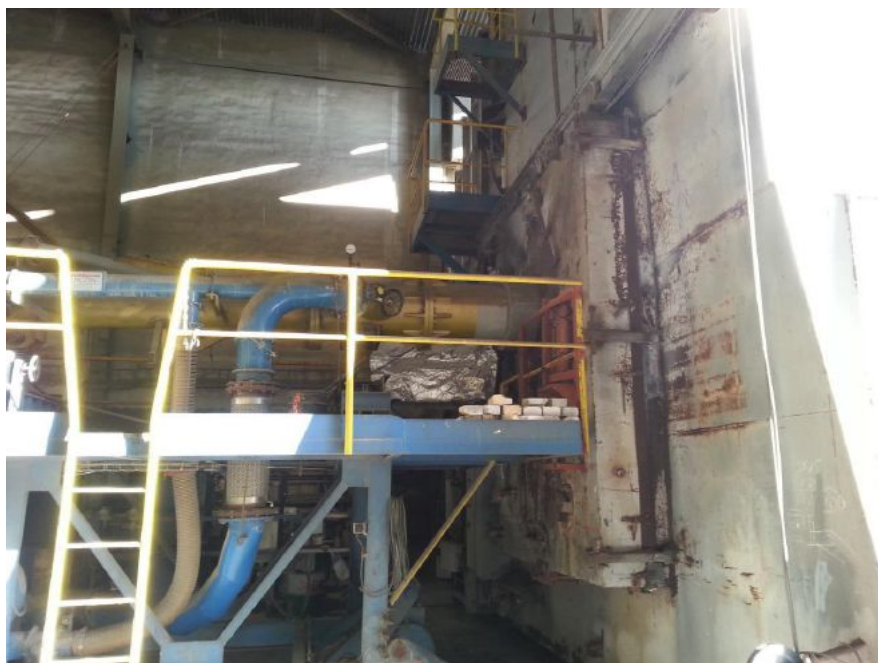
Foto č. 4: Pohled na přívod tekutého paliva do rotační pece
