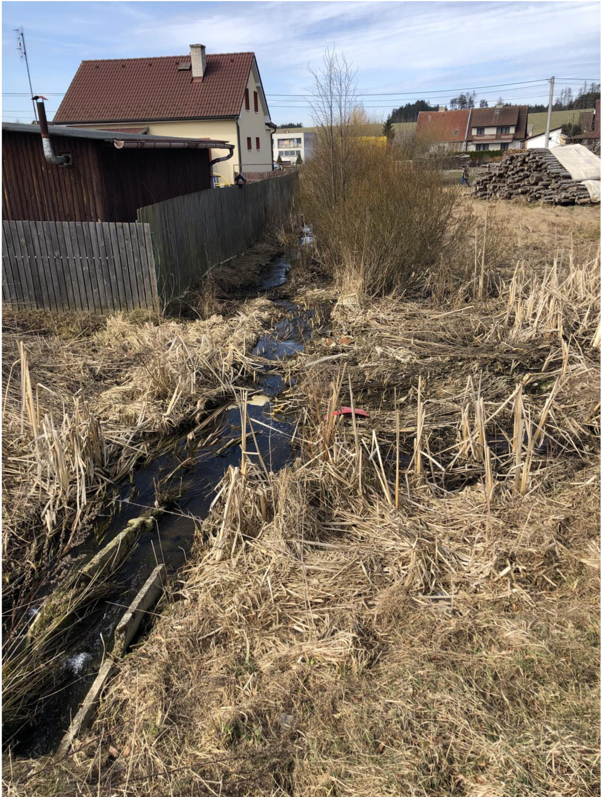
Obr. 13) Odtokové koryto [autor]
