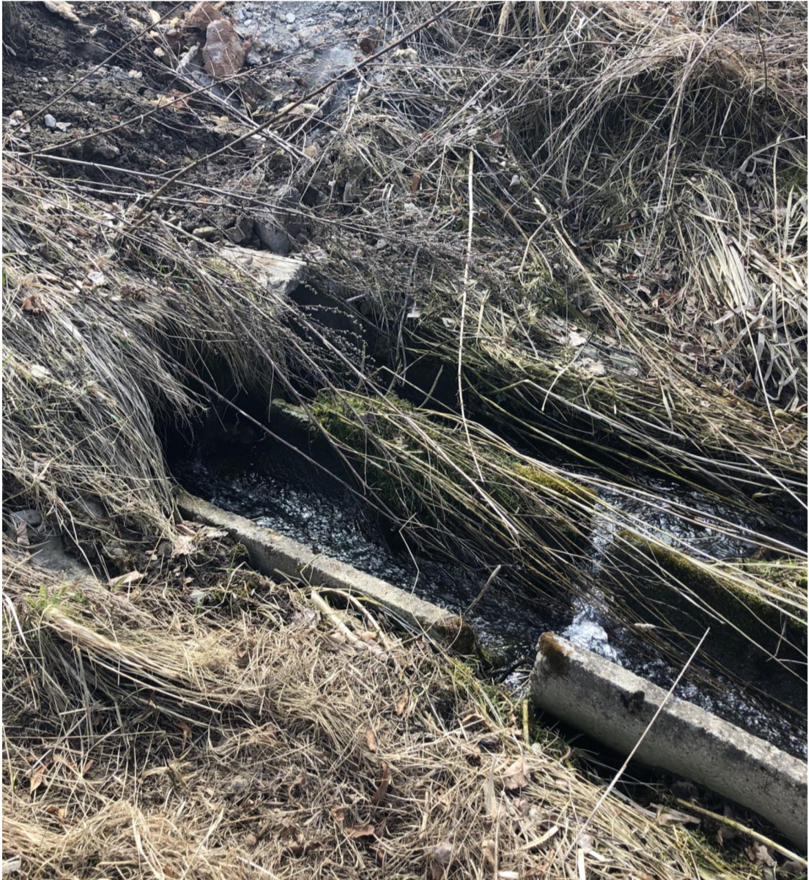
Obr. 12) Odtokové potrubí [autor]
