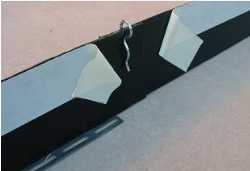
Obrázok 37 - Spojenie plechov svorkou [10]
