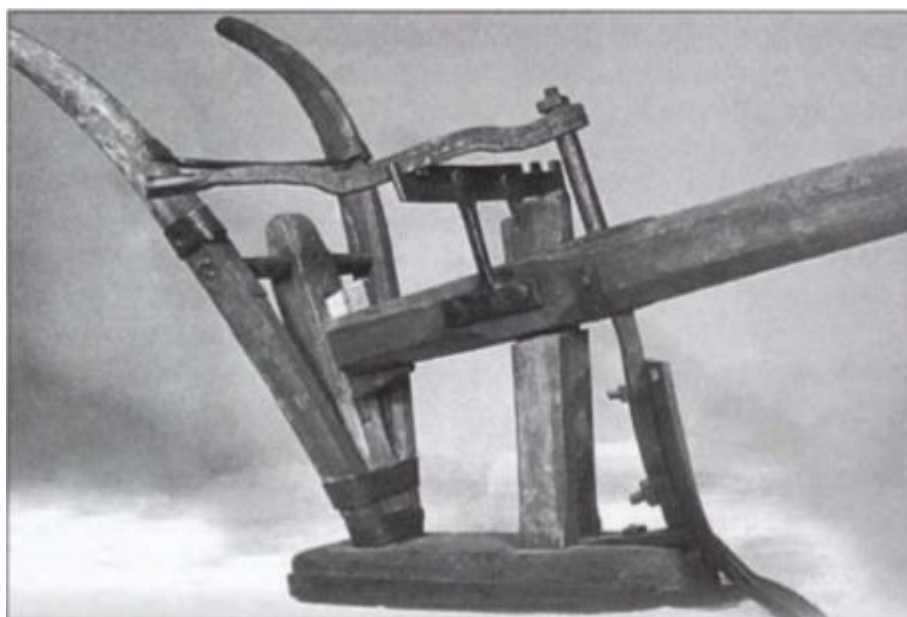
Obrázek 1 – 1. Ruchadlo bratranců Veverkových s otáčivou radlicí
