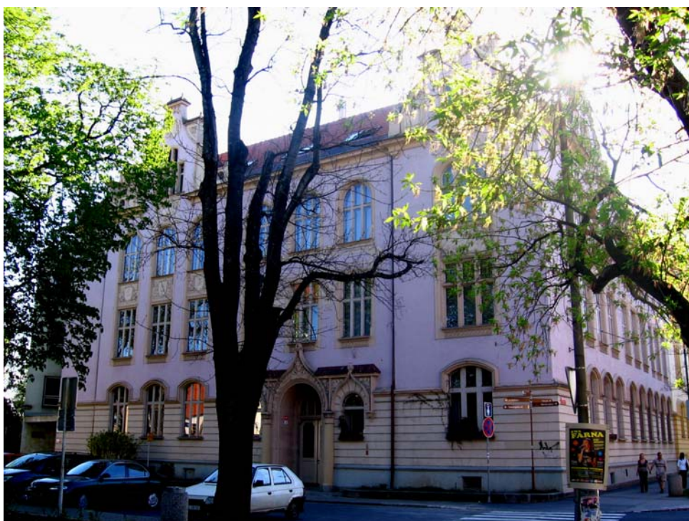
Budova školy na Husově třídě
