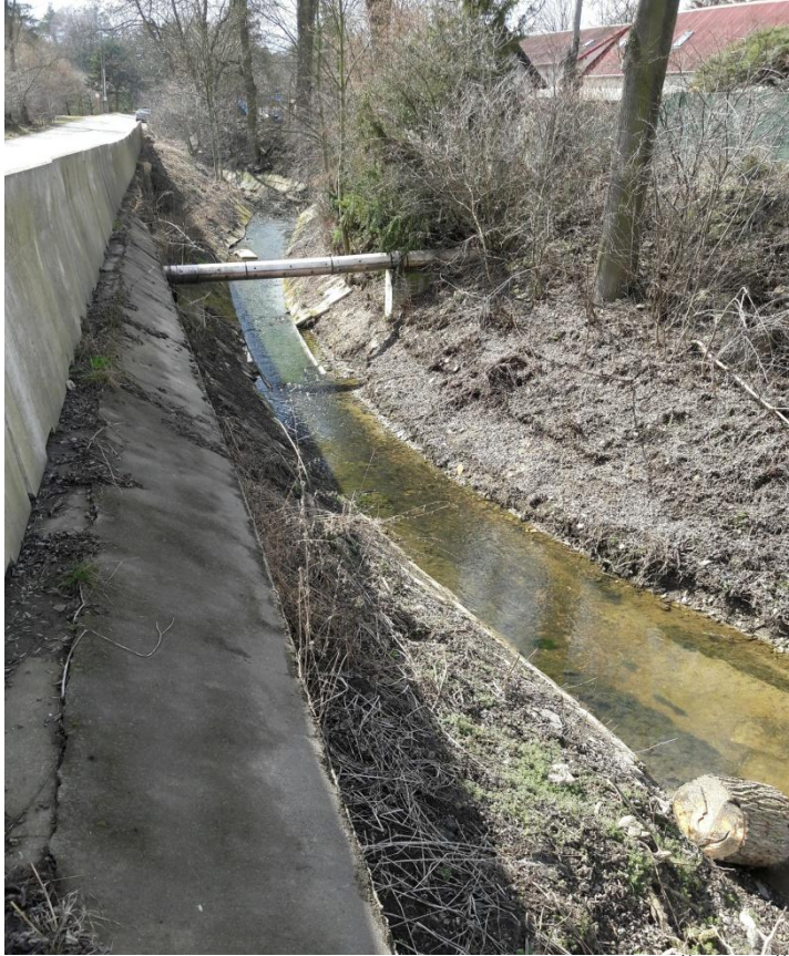
P3 – odběrové místo vybetonované koryto pod ČKV+ČOV Sever
