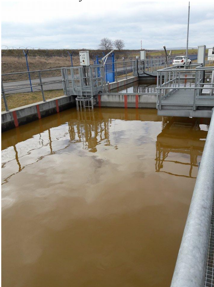
Retenční nádrž odmrazovacích kapalin o objemu 560 m 3
