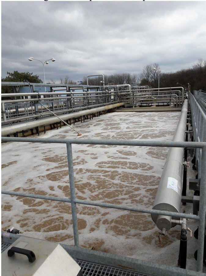
Třetí biologická linka pro čištění srážkových kontaminovaných vod
