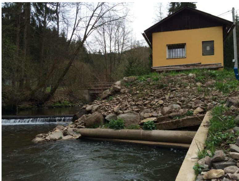
Obr. 3.6 Fotografie odpadního kanálu
