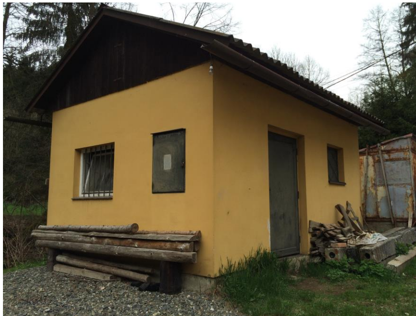
Obr. 3.5 Fotografie budovy elektrárny
