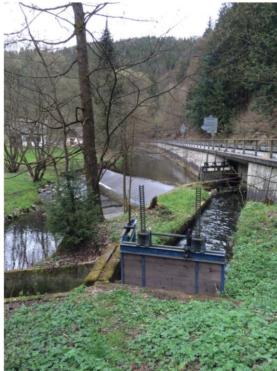
Obr. 3.4 Fotografie vtokového objektu
