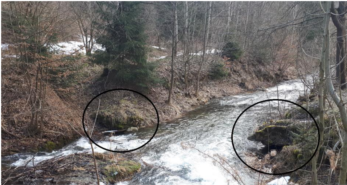
Obr. 45. Relikty kamenného mostu u Holštejna (foto V. Kolomazníček 2019).
