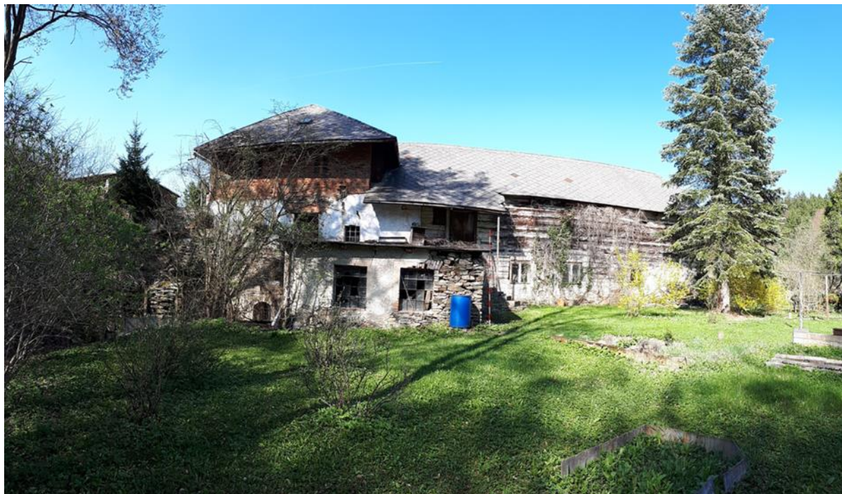
Obr. 19. Celkový pohled na Dolní mlýn z jižní strany. Vlevo, obytný dům (mlýnice), na který navazuje zprava hospodářská budova. Ve dvacátých letech 20. století k nim byla dostavěna kamenná přístavba (foto V. Kolomazníček 2018).
