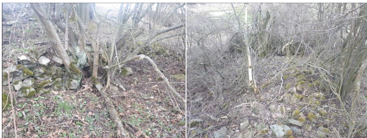
Obr. 23. Torzo kamenné zídky na stráni pod kostelem (foto: V. Kolomazníček 2019).
