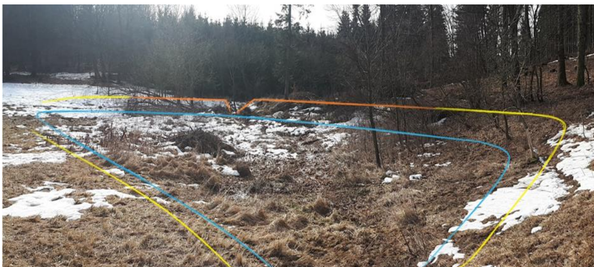
Obr. 42. Zaniklý rybník v ZSO Vaňkouš. Oranžová: torzo hráze. Žlutá: terénní úpravy. Modrá: přibližný rozsah rybníku (zpracoval V. Kolomazníček 2019).
