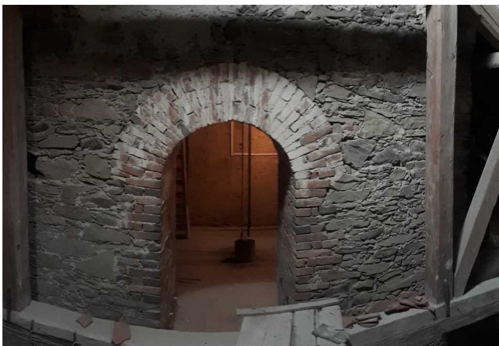
Obr. 15. Vysočany. Kostel v Molenburku (vstup z půdního prostoru do věže), na tento kostel byl údajně použitý sekundárně stavební materiál ze zaniklého kostela v Husí (foto V. Kolomazníček 2019).
