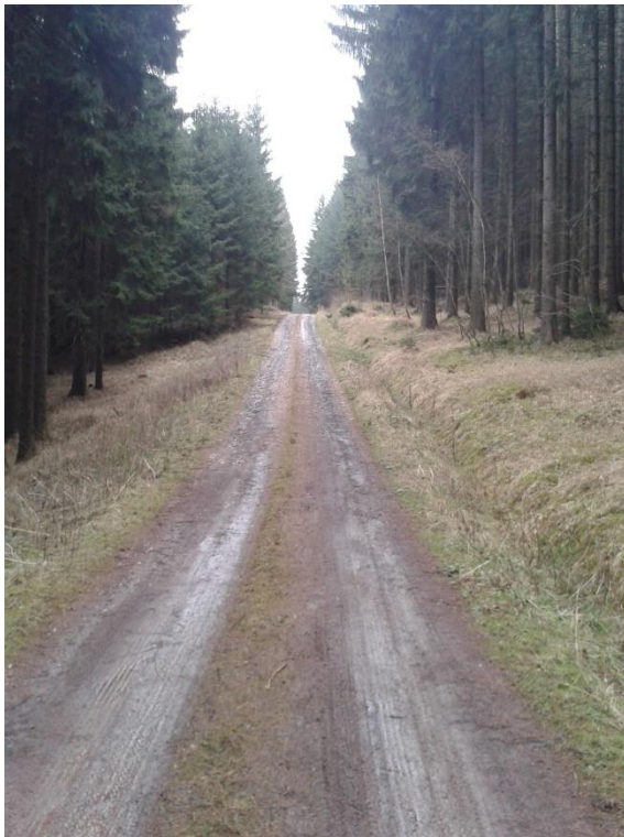
Obrázek 16: Fotografie zpevněné zemní cesty bez poškození na úseku nové cyklotrasy
