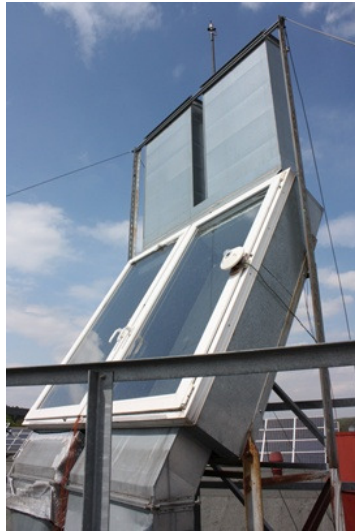
Obr. 3.1 Solární komín - externí část
